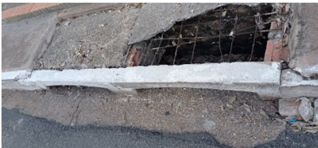
Fotografia 12 - Boca de lobo danificada da Travessa Silva Jardim de Santarém
