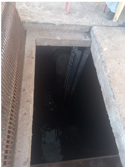
Fotografia 2a - Bomba submersa (fixa)
