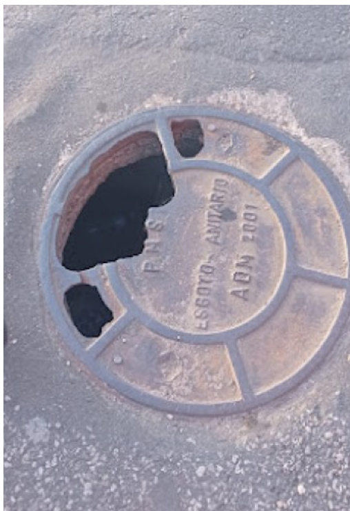
Fotografia 13a - Poço de visita danificado na Avenida Tapajós
