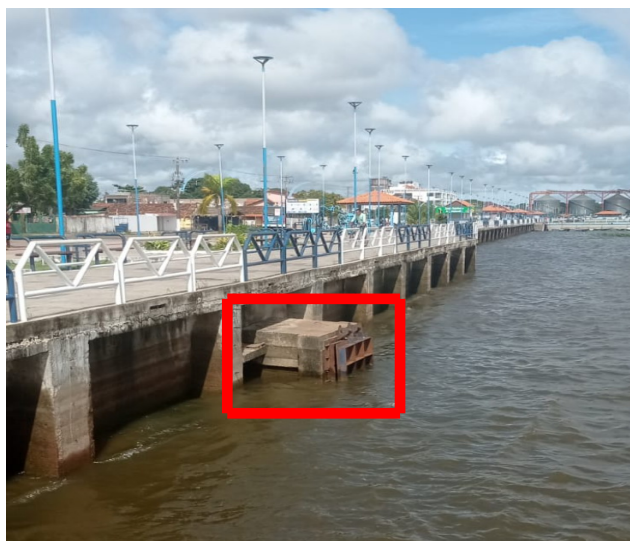
Fotografia 3 - Comporta em tubulação de drenagem no município de Santarém
