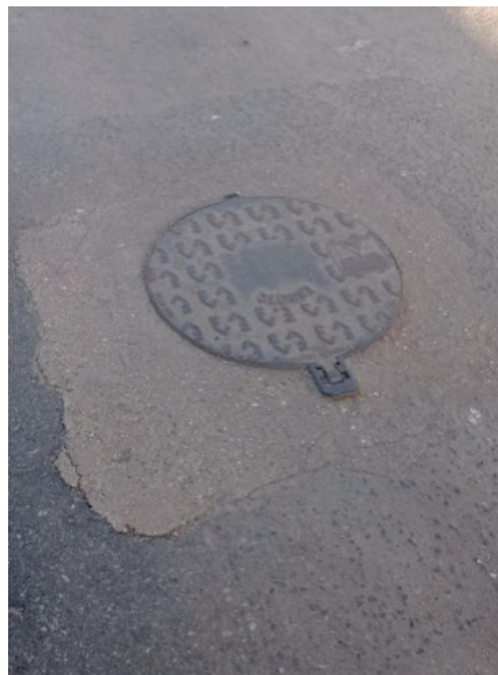
Figura 13b - Poço de visita conservado na Avenida Tapajós
