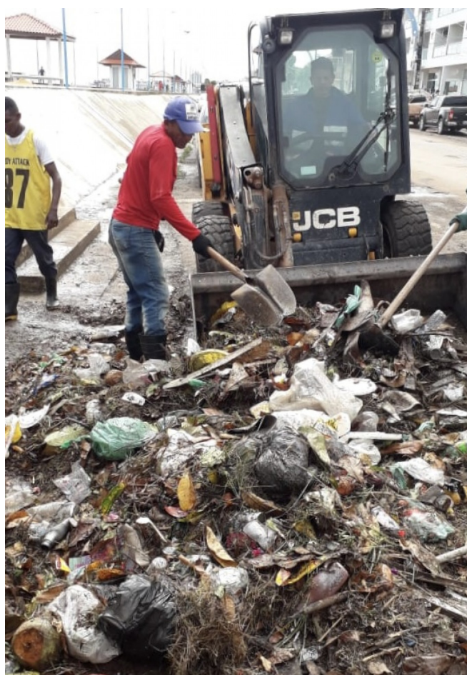
Fotografia 14 - Coleta de resíduos das estruturas de drenagem
