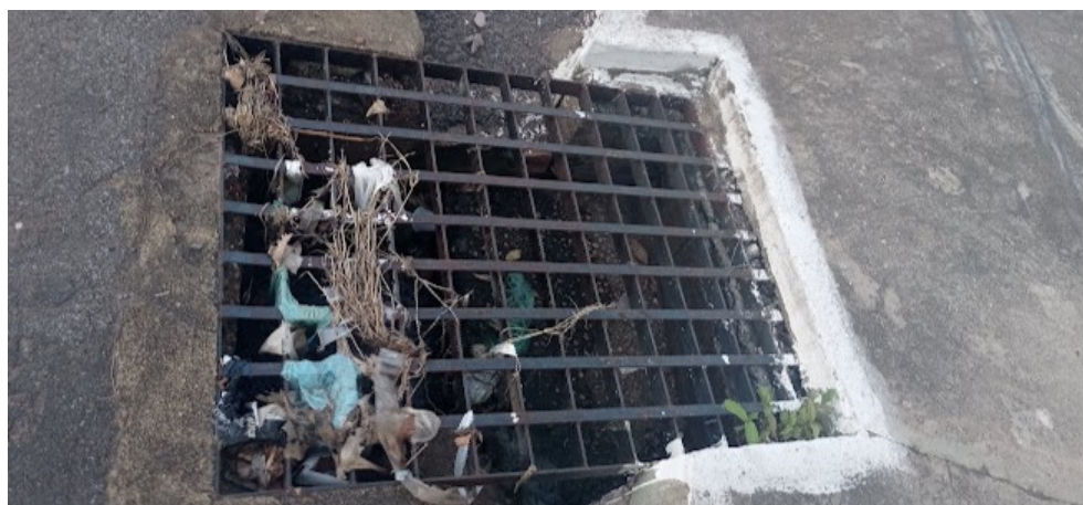
Fotografia 11 - Boca de lobo com grade da Travessa 7 de setembro de Santarém
