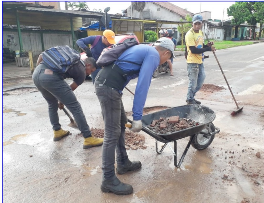
Fotografia 21 - Manutenção asfáltica em via de Santarém
